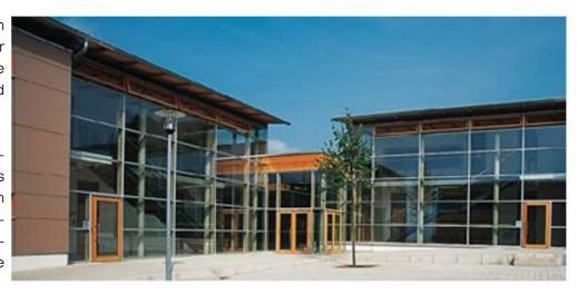
werden. SANCO® SILVERSTAR® N entspricht den hohen Energiespar-Anforderungen. Dies unterstützt zusätzlich der hohe g-Wert des SANCO SILVERSTAR N Wärmedamm Isolierglas.
